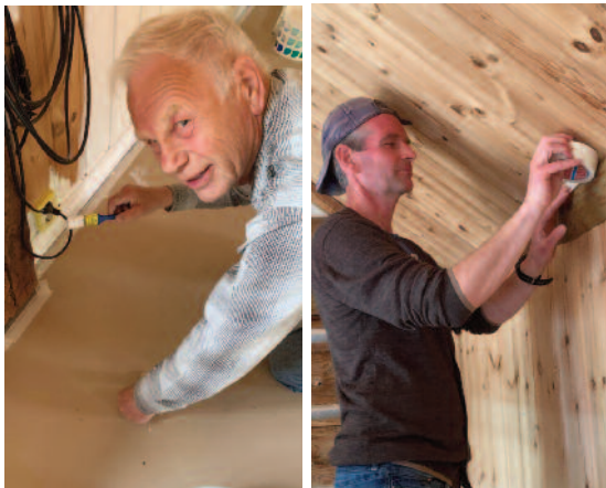
Asbjørn Skøien arbeider lavt. Børge Tjørn arbeider høgt.
